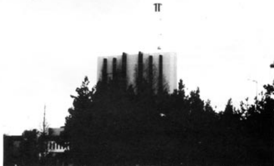
Aggregaten vid Forsmark ligger i naturskön omgivning i hjärtat av Roslagen. (Foto: Tommy Hansson)
